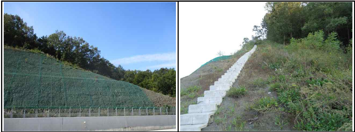
【그림 55.3.4】 보호/보강시설 전경
