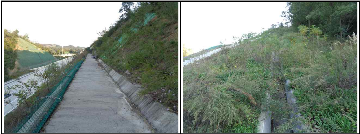
【그림 55.3.3】 배수시설 전경
